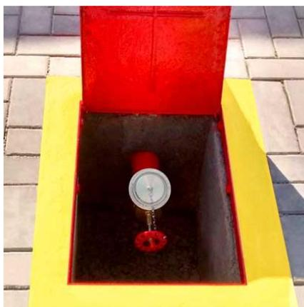
*Dispositivo de recalque instalado no passeio*
