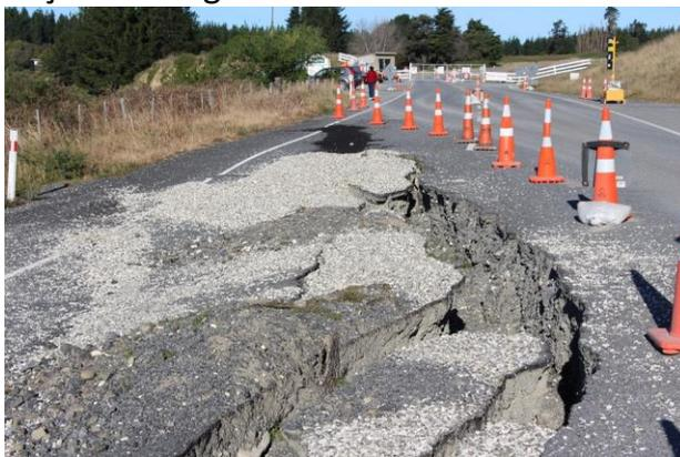
Figura 39: Exemplo de solo colapsível sob pavimento
