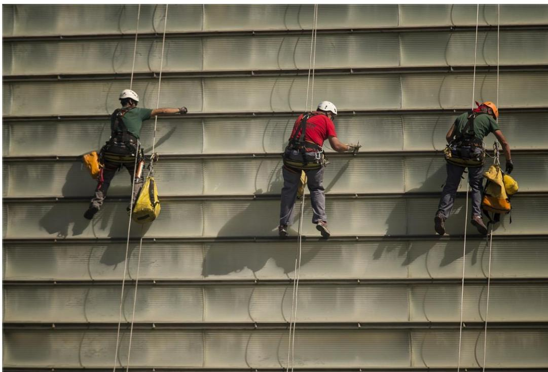
Figura 26: Atividade em altura utilizando cadeira suspensa
