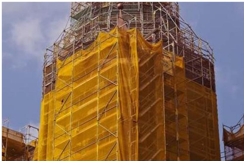
*Figura 31: Telas de proteção contra projeção de materiais*
