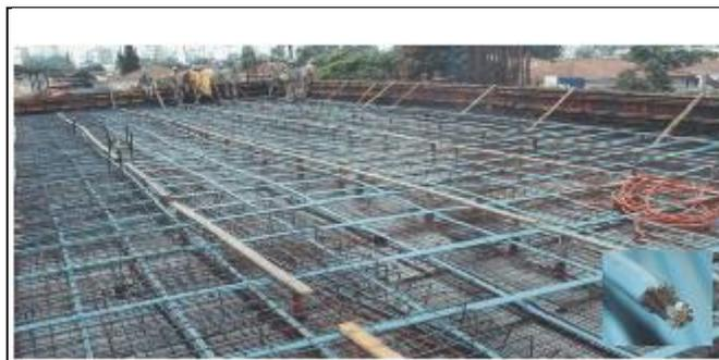
Além disso, os cabos engraxados são leves, de fácil manuseio e flexíveis, o que permite a existência de curvas em sua disposição em planta e possibilita o desvio de eventuais obstáculos existentes em seu trajeto.
